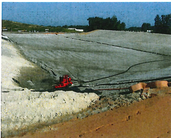
NRRA - Landfill Expansion
