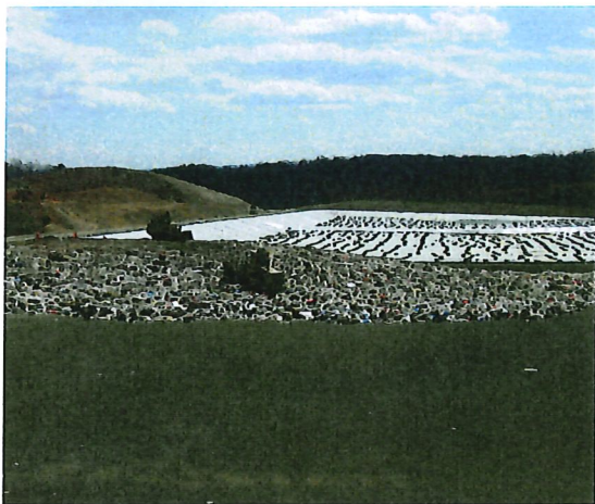
NRRA - Landfill Area C
